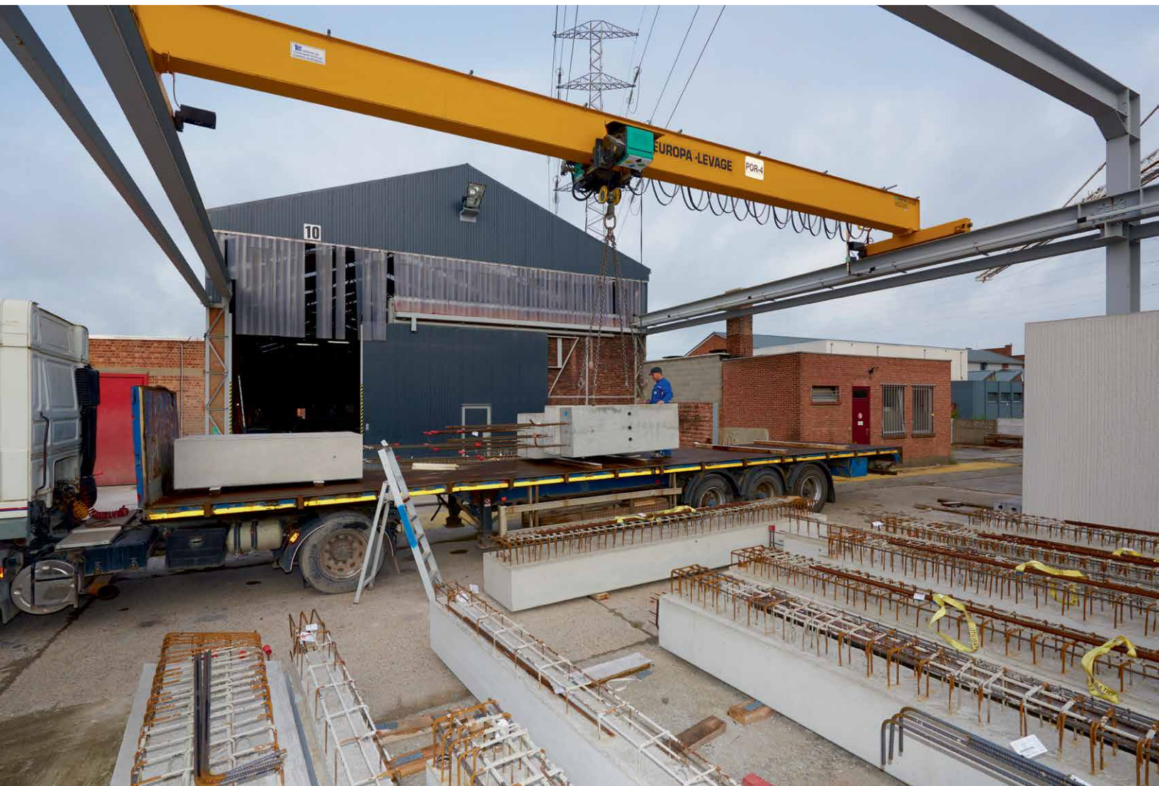
Opslagplaats CIT Blaton, dienst betonwapening, dienst prefabricatie, werfmateriaal
